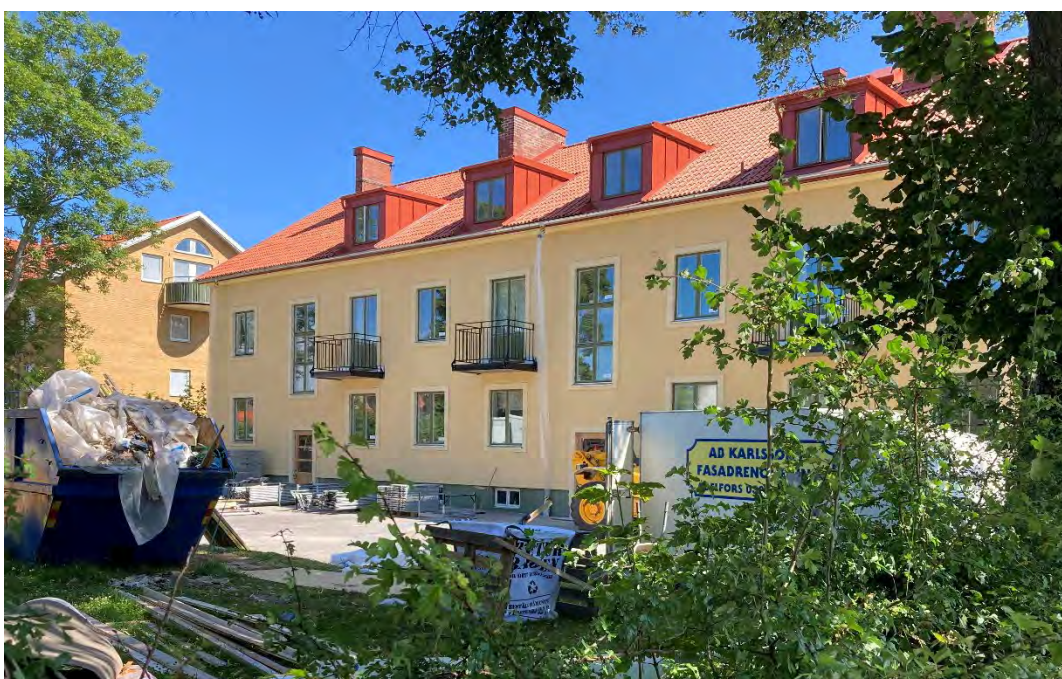
Bild från pågående renovering sommaren 2024.
