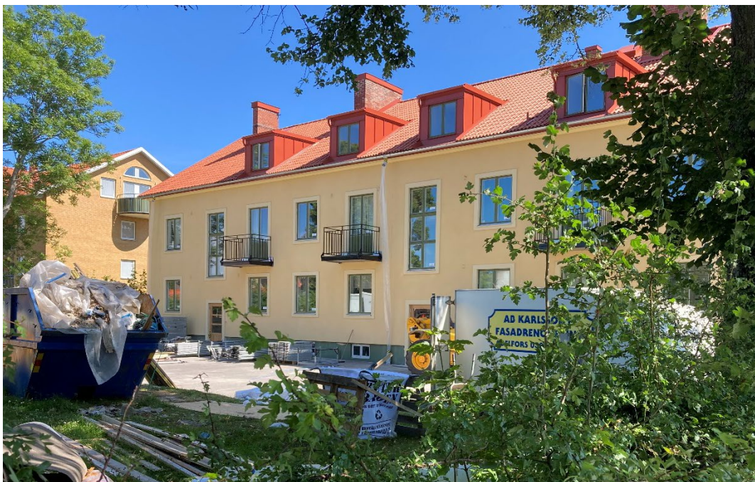
Bild från pågående renovering sommaren 2024.
