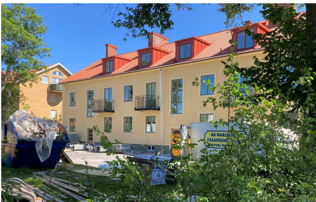
Bild från pågående renovering sommaren 2024.
