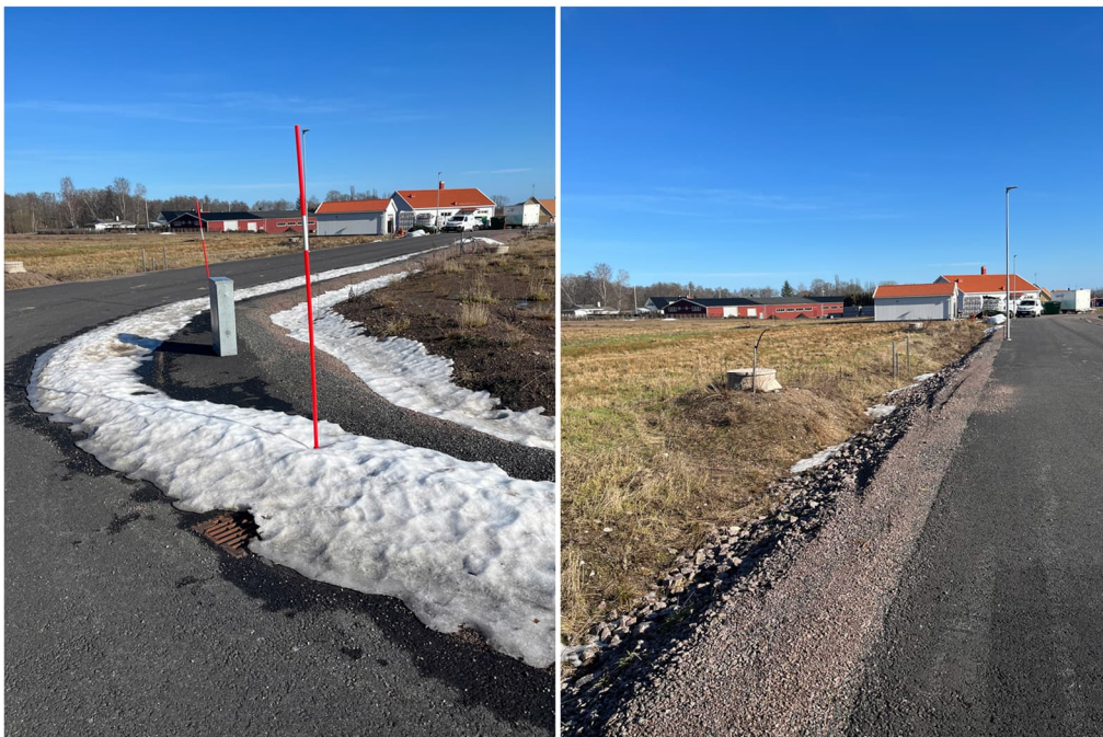
Figur 17. Det fanns ett flertal jämt utplacerade gallerbrunnar på Rönnbärsstigen samt grävda diken för avledning av vatten längs båda sidor av gatan.
