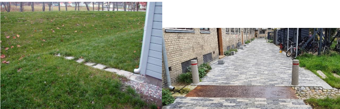
Figur 29. Höger bild -erosionsskydd för bortledning av takvatten från stuprör (Stockholm Vatten och Avfall, 2017a). Vänster bild – från rännaldalen leds vattnet via stenlagd yta.
